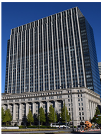
明治安田生命ビル(明治生命館含む)
